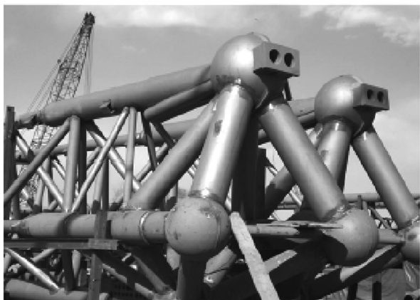
图12 拉索锚固节点
