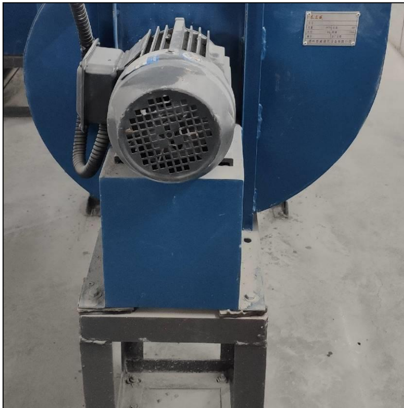
图 4-4 减震基础
