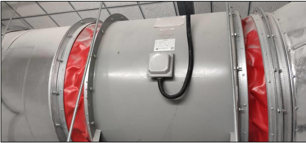
图 4-5 风管软连接
