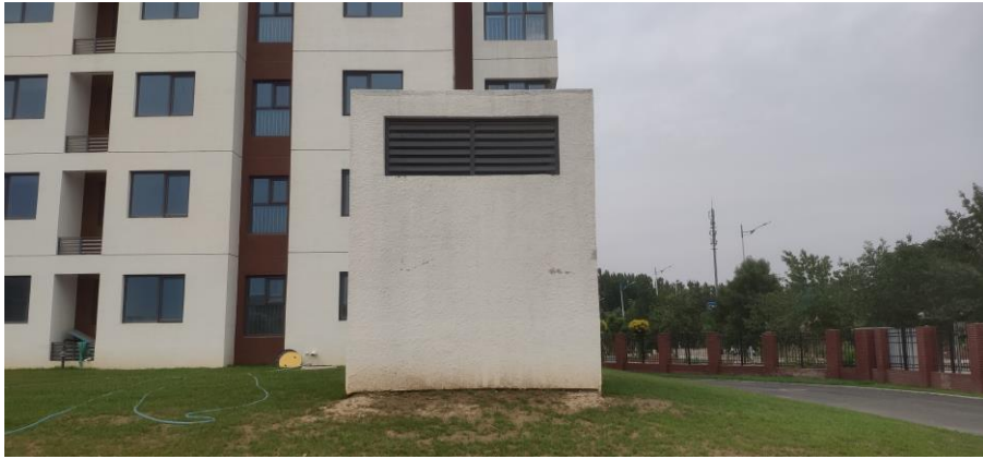
图 4-2 地下车库排风口
