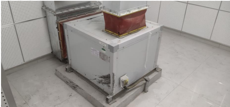
图 4-5 减震基础
